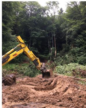
Sur le chemin des Gares à Peney-le-Jorat, les agriculteurs pouvaient déposer les pierres des champs. Il a été fermé car il est situé dans une zone de source. Le chemin a été remis en état, une couche de finition/fermeture a été posée sur les pierres. Afin de dissuader les cavaliers de passer dans le peuplement, de gros cailloux ont été déposés le long du chemin et les forestiers-bûcherons ont également planté des arbres.
