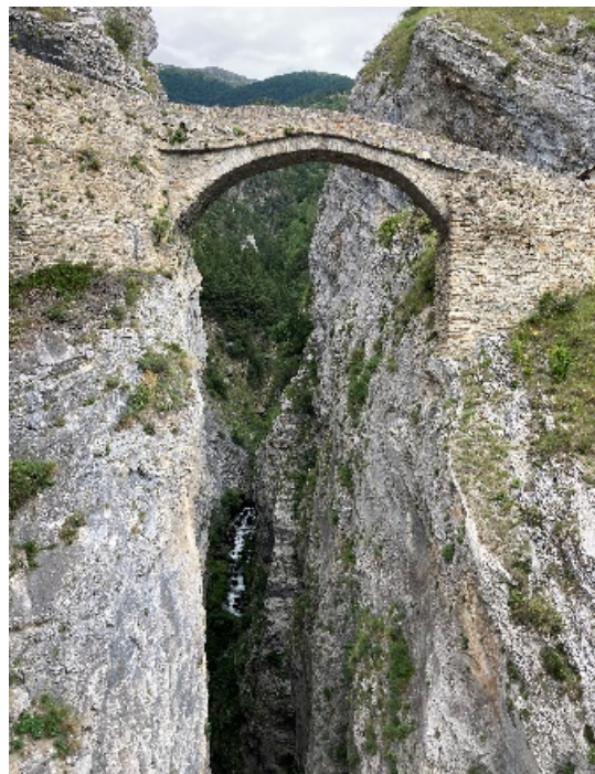
Pont sur la route de Loèches-Bratsch
